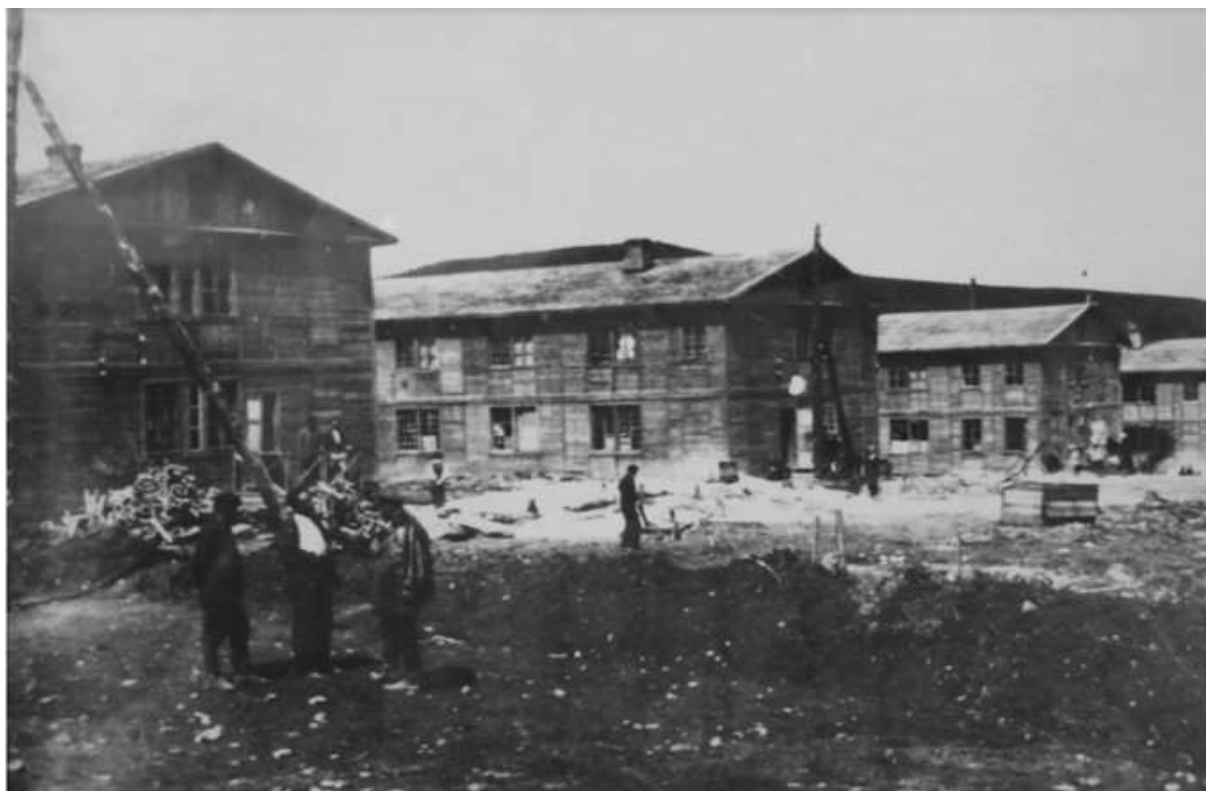
Výstavba typových bytových domů
